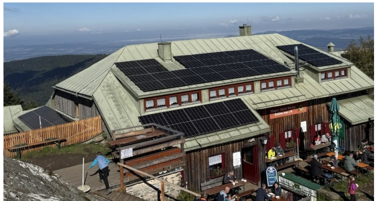
Osserschutzhäus mit Photovoltaikmodulen
