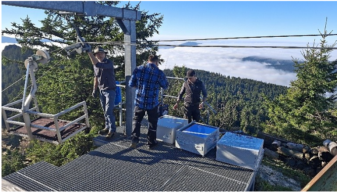
Materialtransport mittels Lastenaufzug
